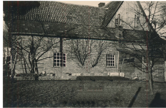
Haus Nettelhoff von Gunethe aus gesehen
