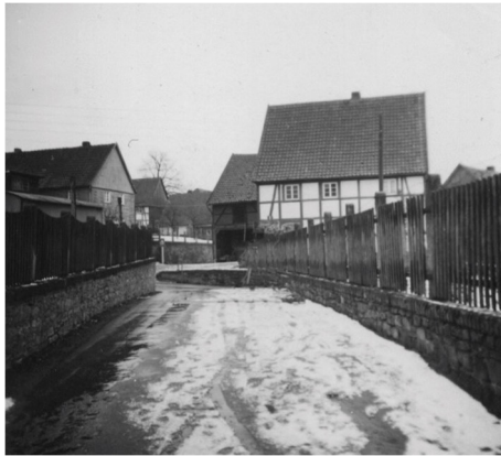
Haus Hershoff (Quente) vom Katanienweg aus gesehen
